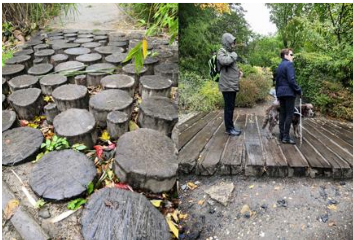
Obrázek 47: Nevhodně zvolená a nebezpečná pochůzná plocha
