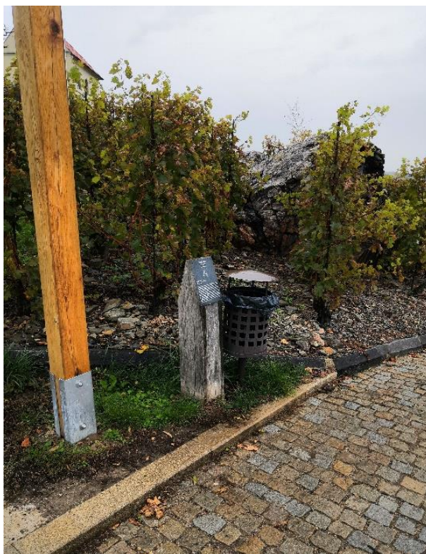
Obrázek 21: Nevhodně umístěný sloup u odpadkového koše
