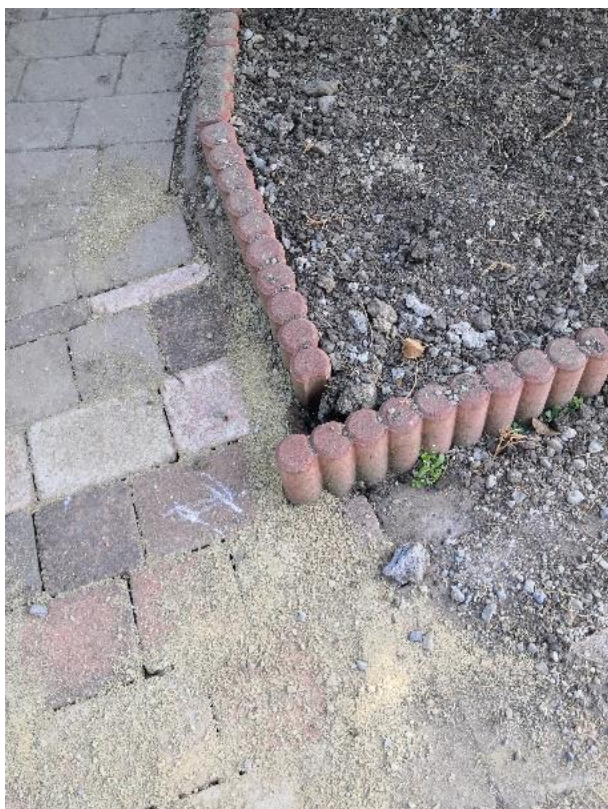
Obrázek 39: Vyčnívající obrubník do pochůzně plochy
