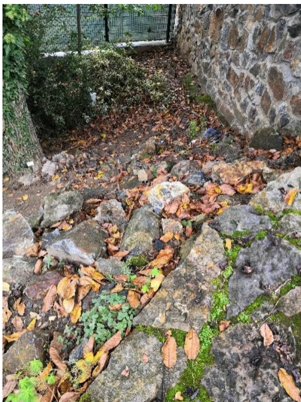
Obrázek 36: Chodníček bez zábradní na okraji srázu
