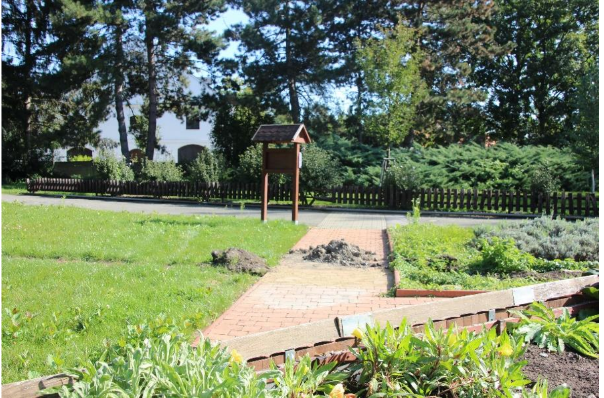
Obrázek 38: Nevhodně umístěná hlína a nezajištěný výkop
