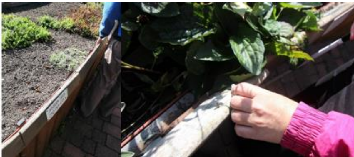
Obrázek 43: Nevhodně zakončený vyvýšený záhon dřevěnou obrubou, které trpí povětrnými vlivy, špatná údržba – vyčnívající hřebík
