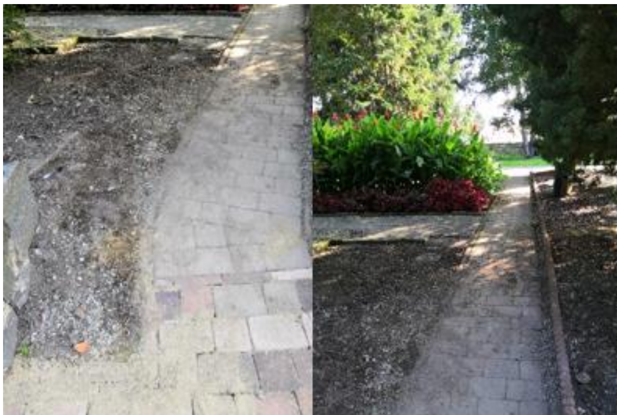
Obrázek 40: Neupravený chodník, písek na pochůzně ploše - nebezpečí pádu
