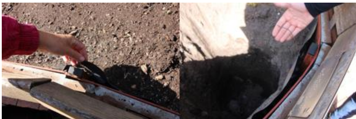
Obrázek 44: Vyčnívající ostrá nopová fólie a drát k přichycení nopové fólie
