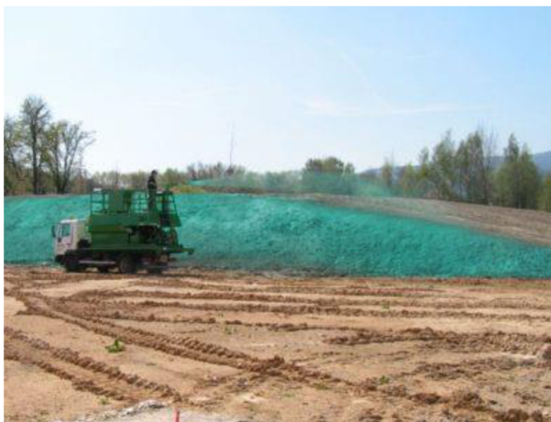
Obrázek č. 23: Aplikace hydroosevu věžovou stříkací jednotkou (snadnytravnik.cz b.r. dostupné z https://snadnytravnik.cz/hydroosev/ )
