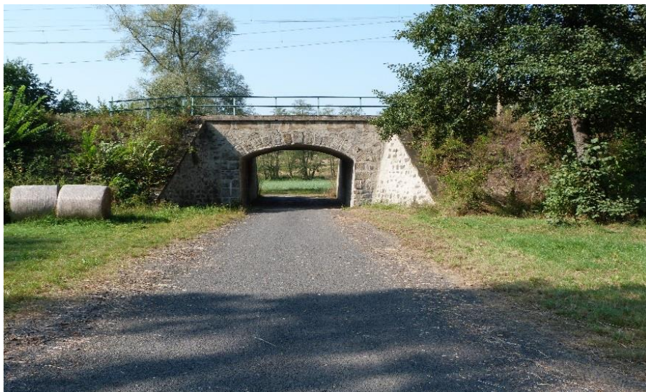
Obrázek 9 Ukázka výstavby cest po realizaci září 2016
