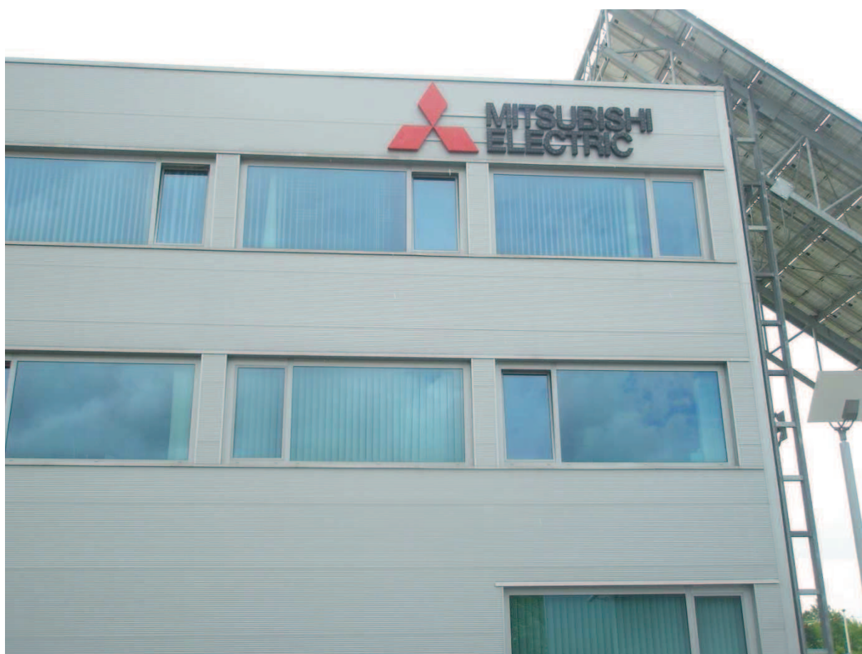
Obr. 33 Pohled na západní fasádu objektu
