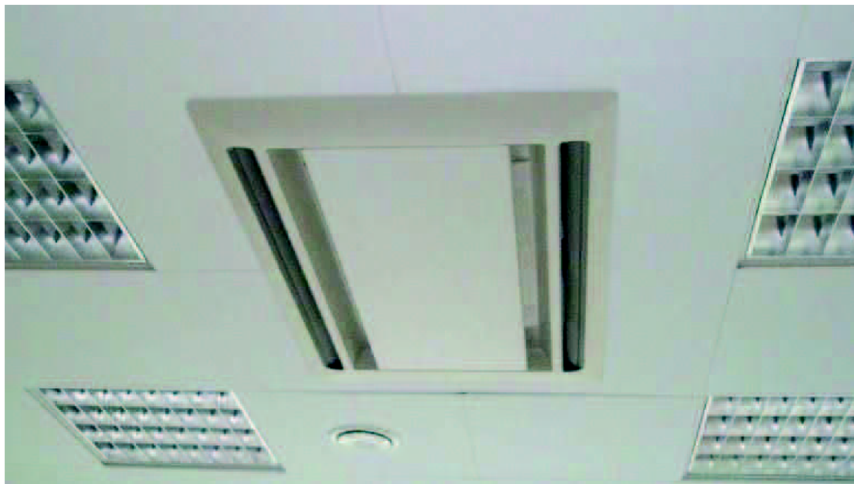
Obr. 36 Vnitřní dvoucestná kazetová jednotka PLFY-P25 VLMD, osazena v sádkartonovém podhledu spolu s osvětlením a přívodním ventilem
