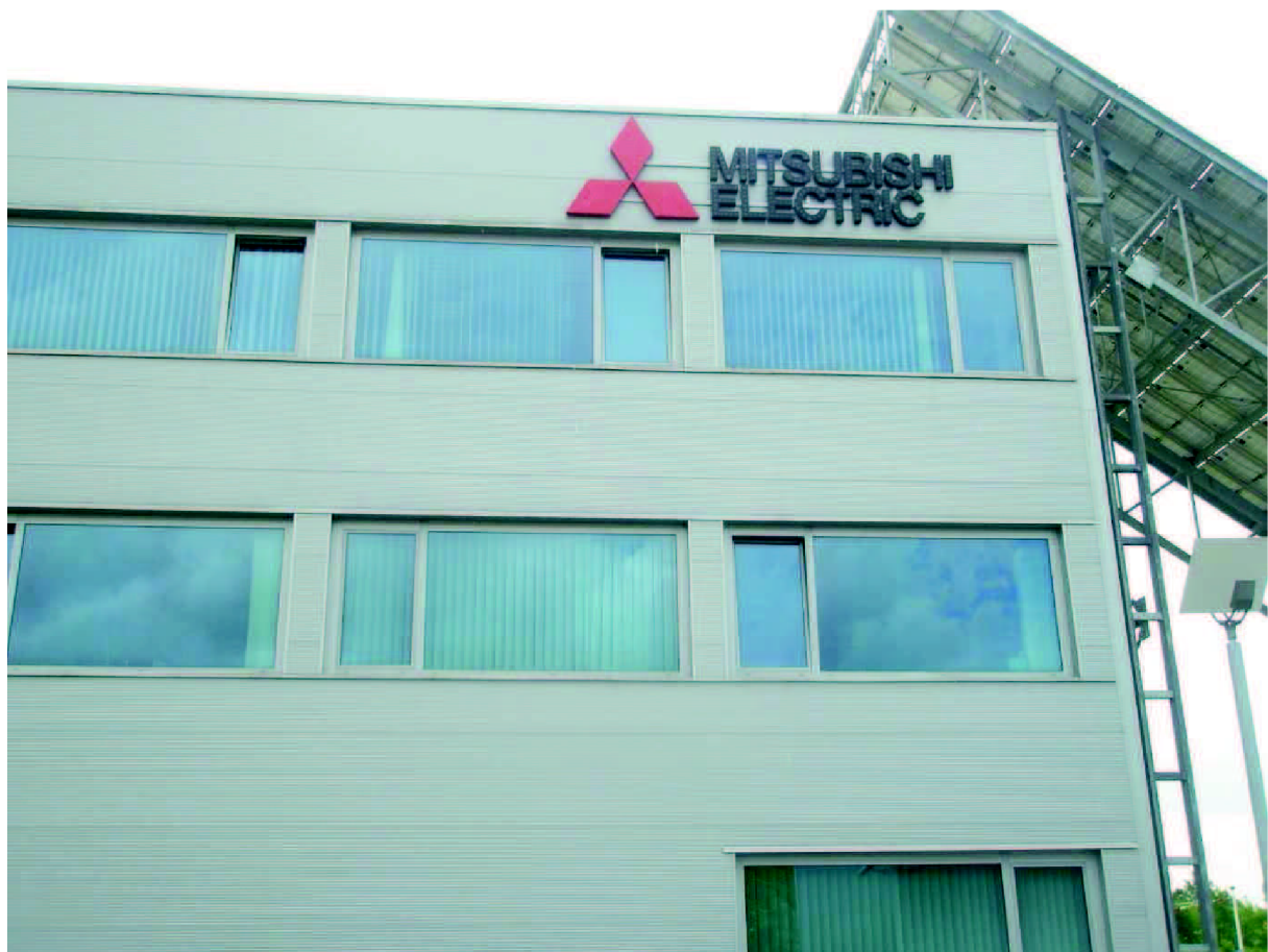
Obr. 33 Pohled na západní fasádu objektu
