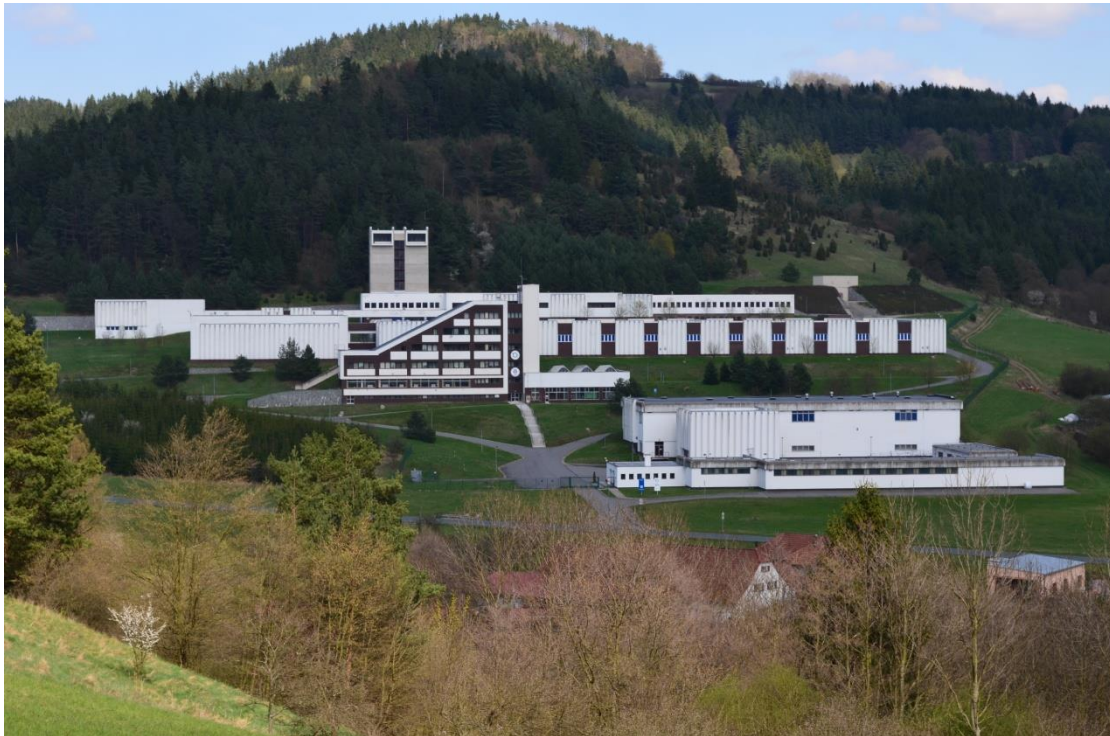
Obrázek 2: Úpravna vody Švařec
