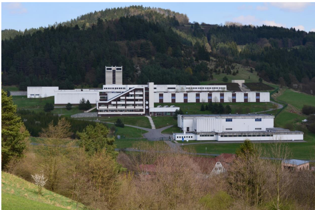
Obrázek 2: Úpravna vody Švařec
