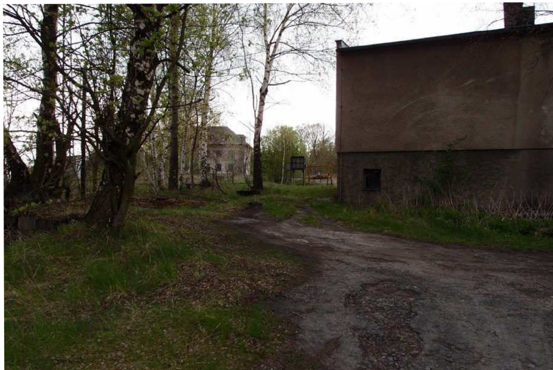
Příloha č. 2 – Fotografie přístupové cesty
