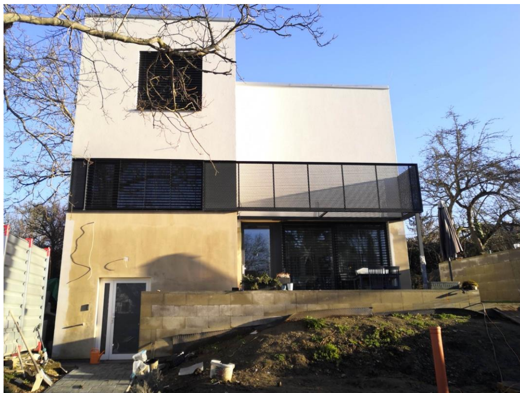
Obr. 12: Fotografie popisovaného domu (vlastní fotografie)
