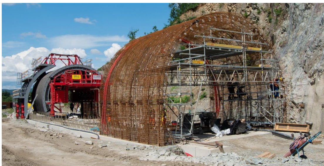
Obr. 12 Armatura jednoho pasu
