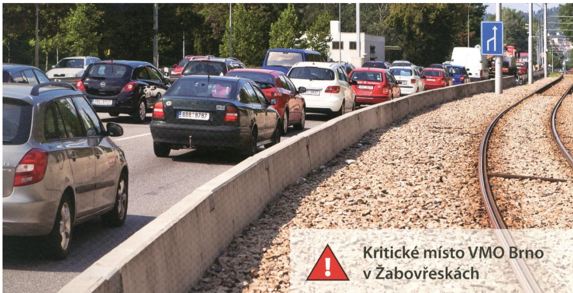
Obr. 2 Kritické místo během výstavby
