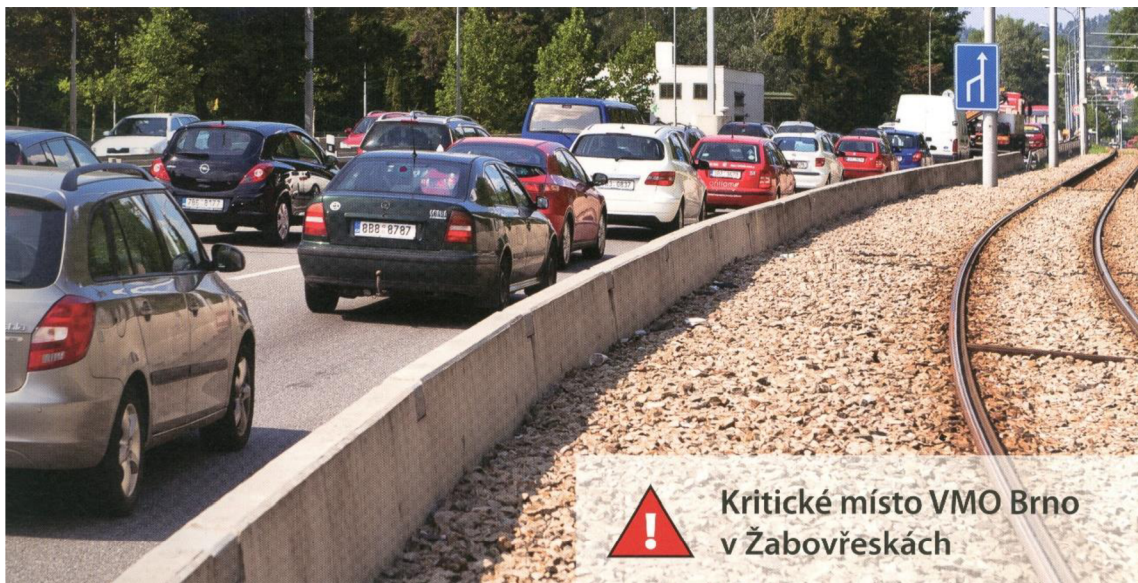
Obr. 2 Kritické místo během výstavby
