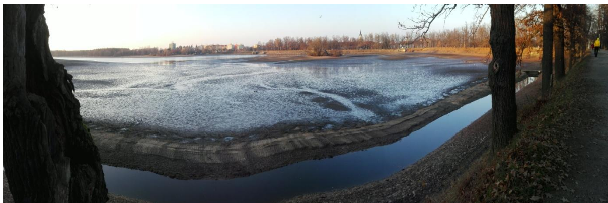
Obr. 25 - Panoramatický pohled z hráze na vypuštěný rybník Svět (foto autor).
