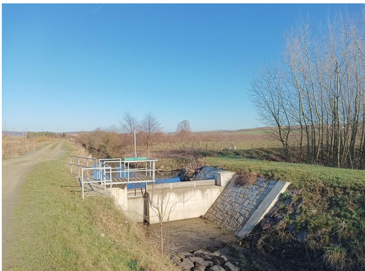
Obrázek 7 – Ukázka úprav po PÚ (vodohospodářské úpravy k.ú. Ořechov)
