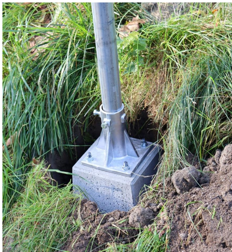
Obrázek č. 23: Usazená betonová patka dopravní značky
