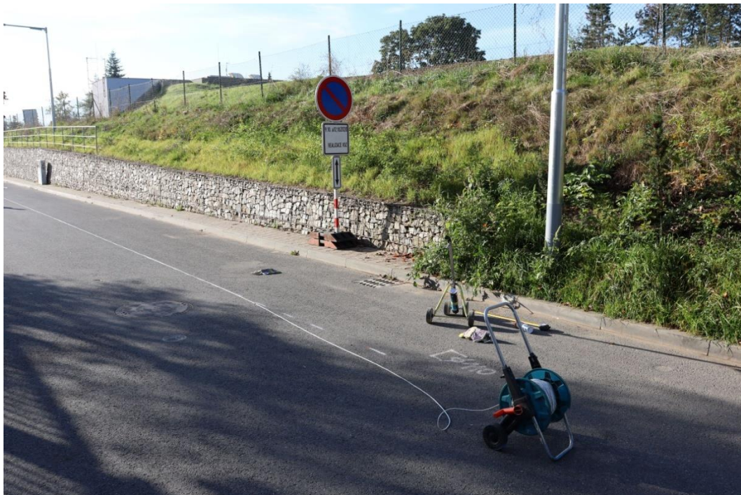
Obrázek č. 21: Značení bílé přerušované čáry
