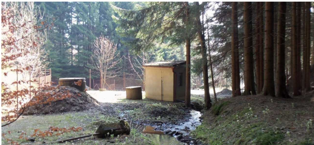
Obr. 2.2 Sběrné studny, bývalá dávkovací stanice chloru
