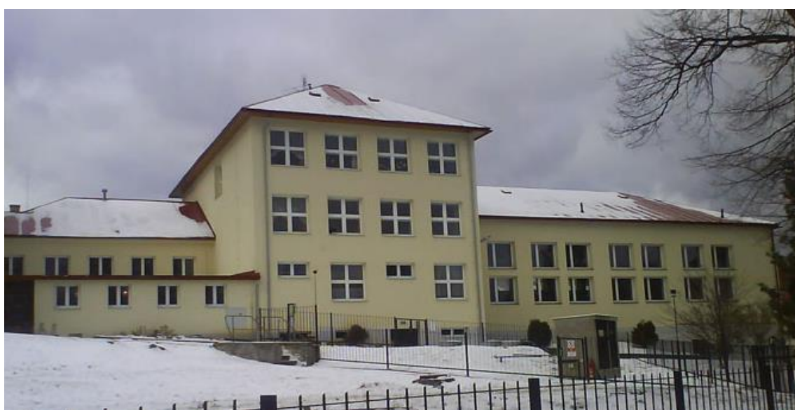
Foto 39 Zateplená budova základní školy ve Stachách [39]
