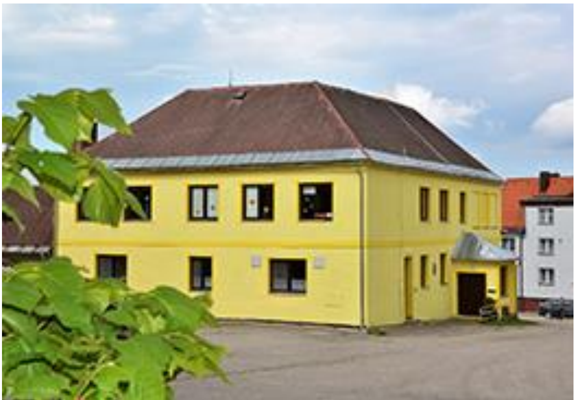
Foto 33 Původní budova malotřídní školy ve Zbytinách s novou fasádou [33]
