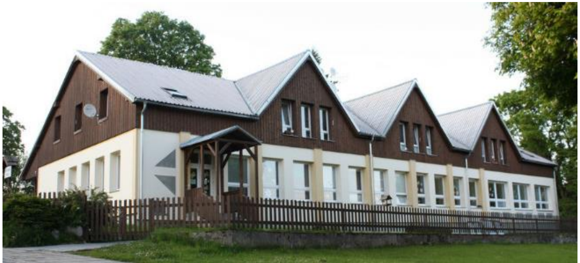
Foto 35 Budova malotřídní školy ve Strážném [35]
