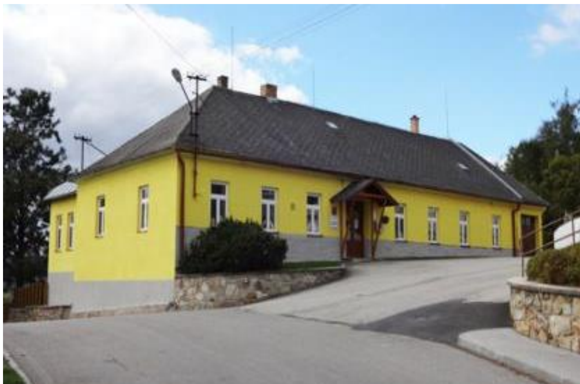
Foto 28 Zrekonstruovaná stará budova malotřídky ve Svaté Maří [28]
