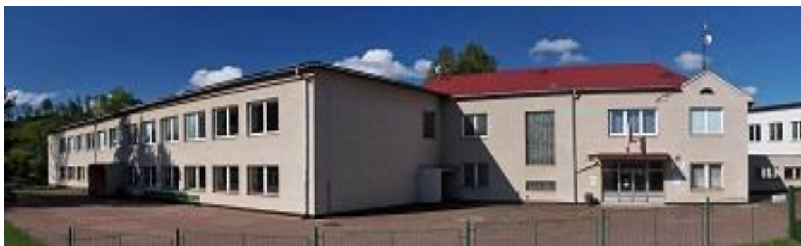
Foto 38 Budova základní školy s novými okny ve Čkyni [38]
