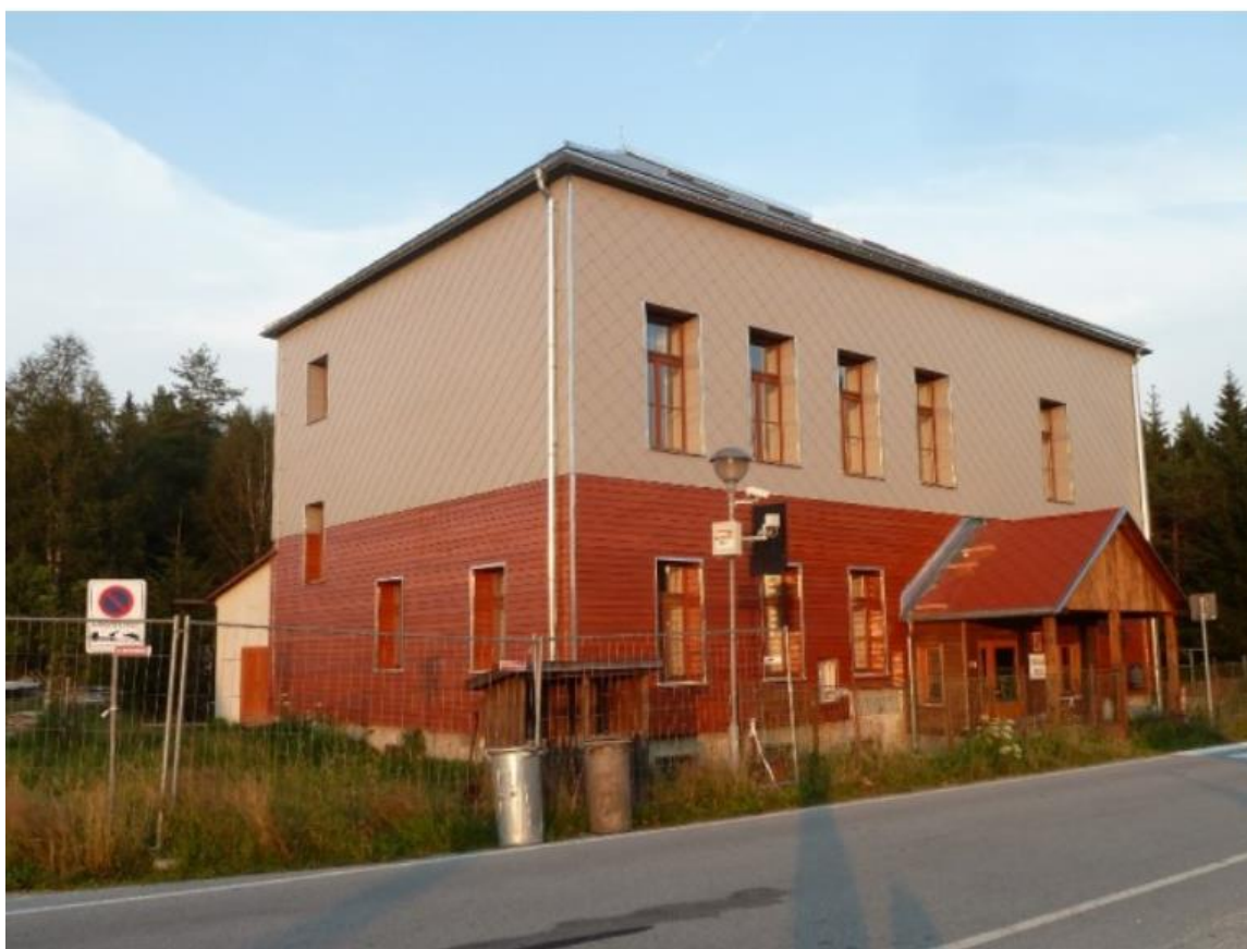
Foto 31 Budova malotřídky v Borových Ladech po kompletní rekonstrukci v roce 2015 [31]
