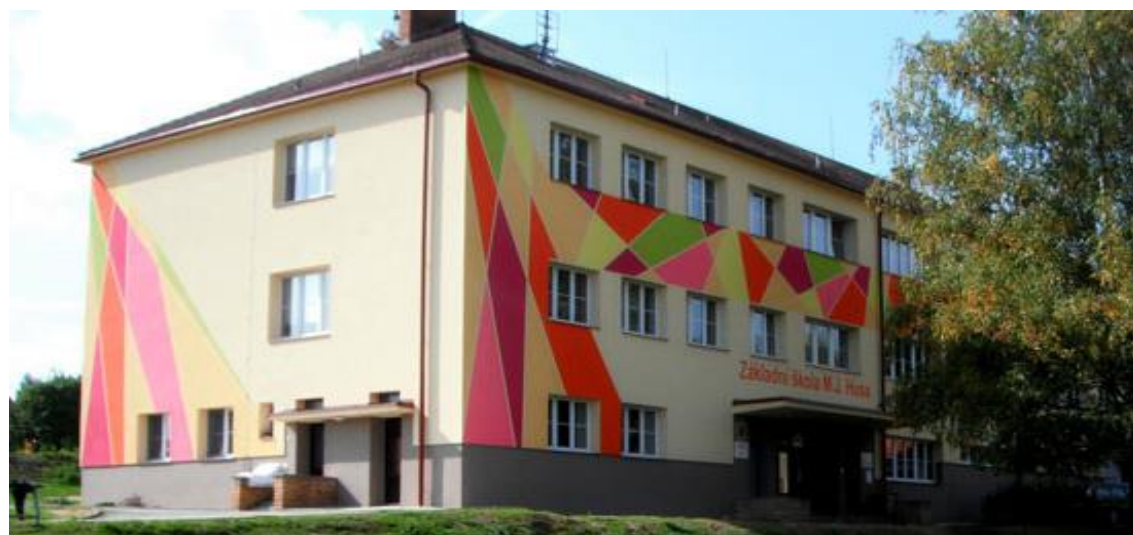
Foto 45 Zateplená a nově omítnutá budova základní školy v Husinci [45]
