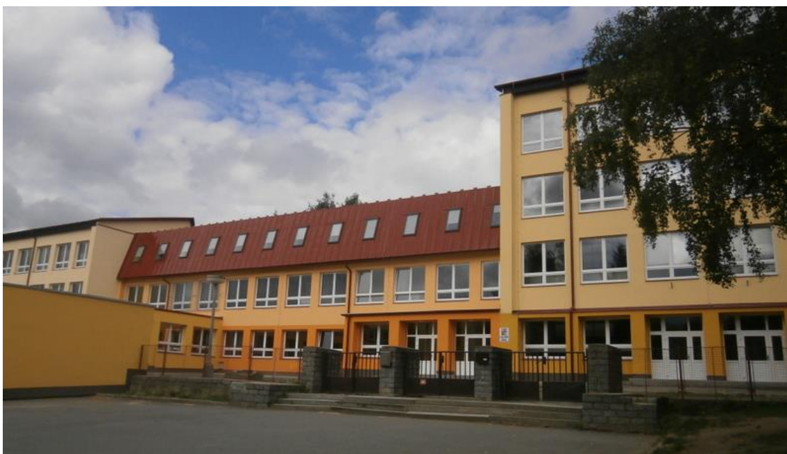
Foto 49 Budova základní školy Smetanova ve Vimperku po kompletní rekonstrukci v roce 2014 [49]
