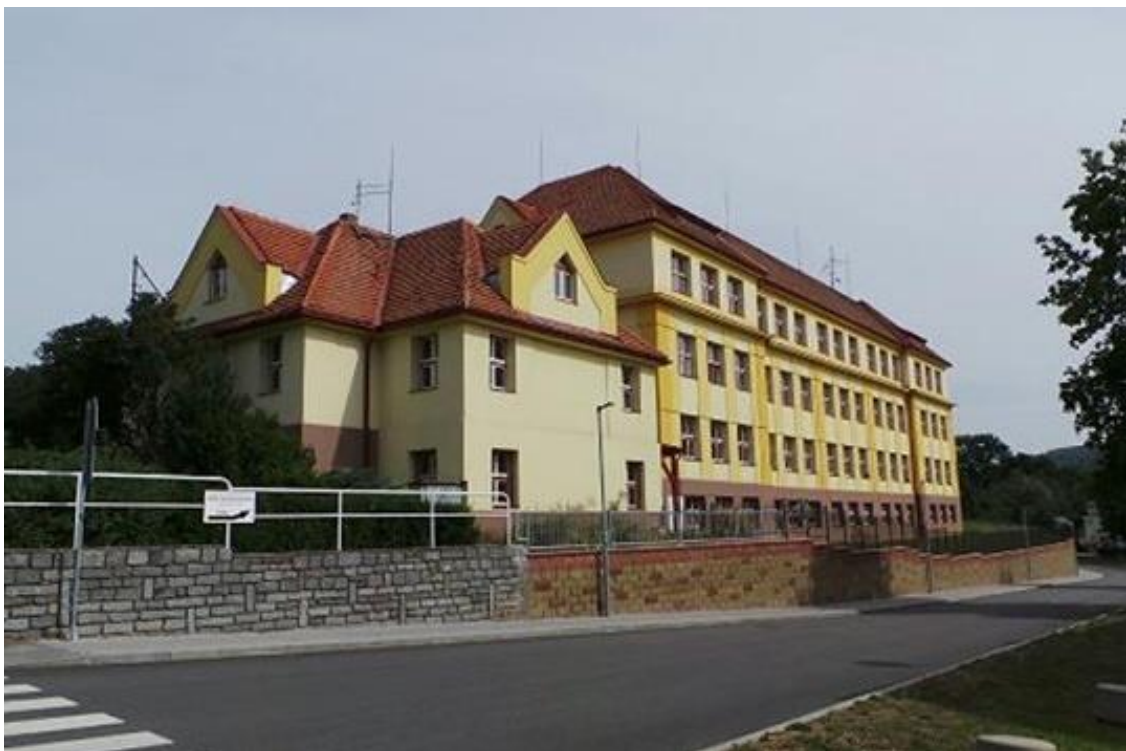
Foto 52 Budova základní školy Vodňanská ležící na okraji města Prachatice [52]
