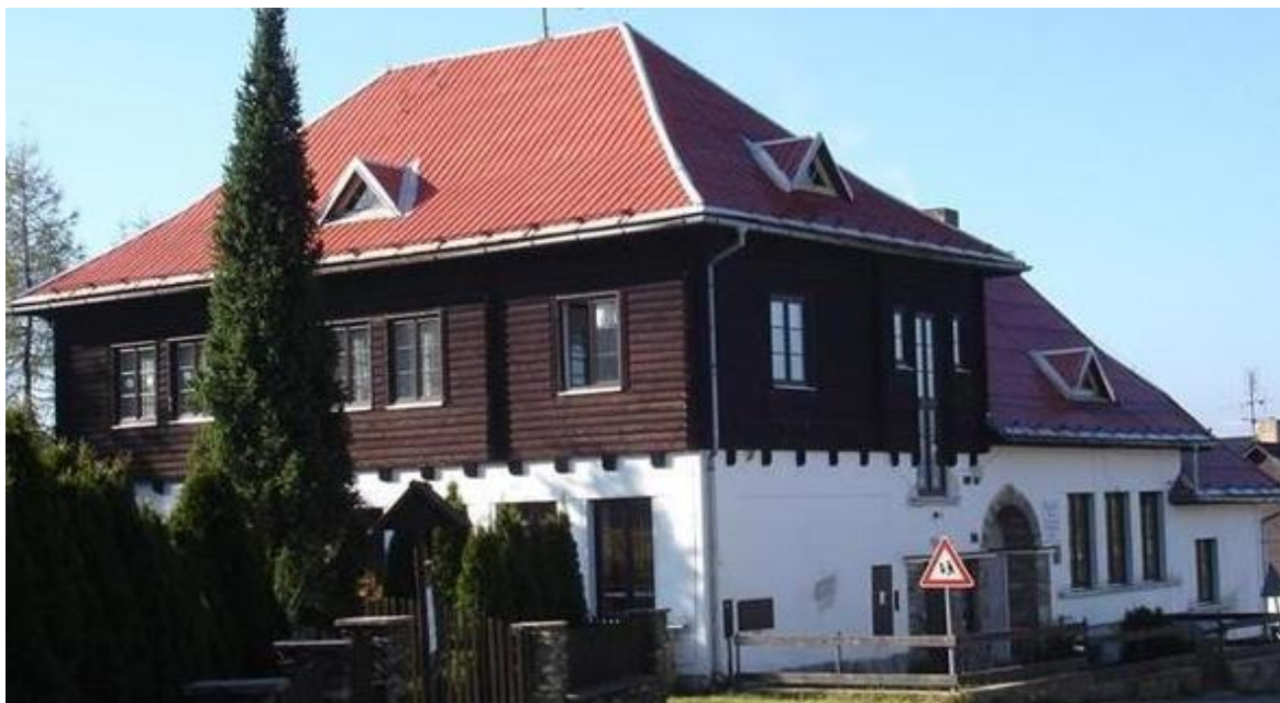
Foto 7 Budova bývalé základní školy ve Stožci [7]
