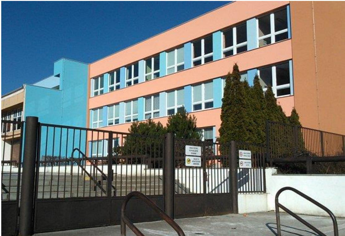
Foto 51 Zrekonstruovaná budova základní školy Národní v Prachaticích z roku 1990 [51]
