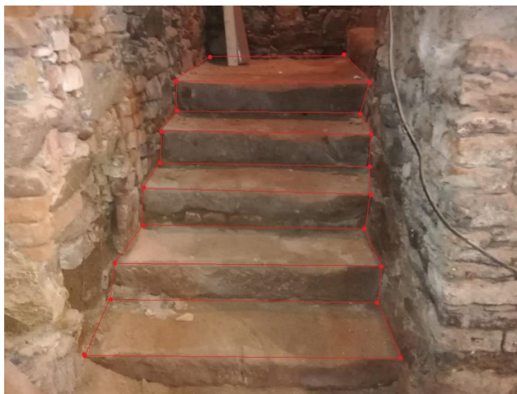
Obr. 14 Ukázka zaměření schodiště
