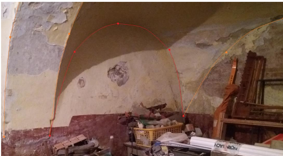
Obr. 13 Ukázka zaměření klenby
