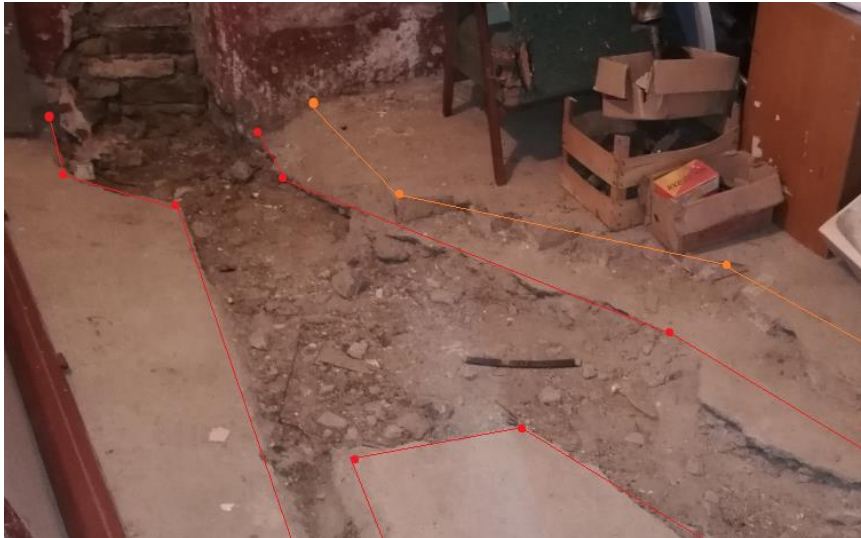
Obr. 24 Ukázka zaměření nerovností podlahy
