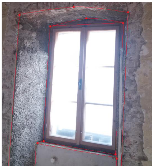
Obr. 15 Ukázka zaměření okenního otvoru
