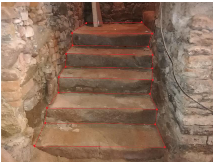
Obr. 14 Ukázka zaměření schodiště
