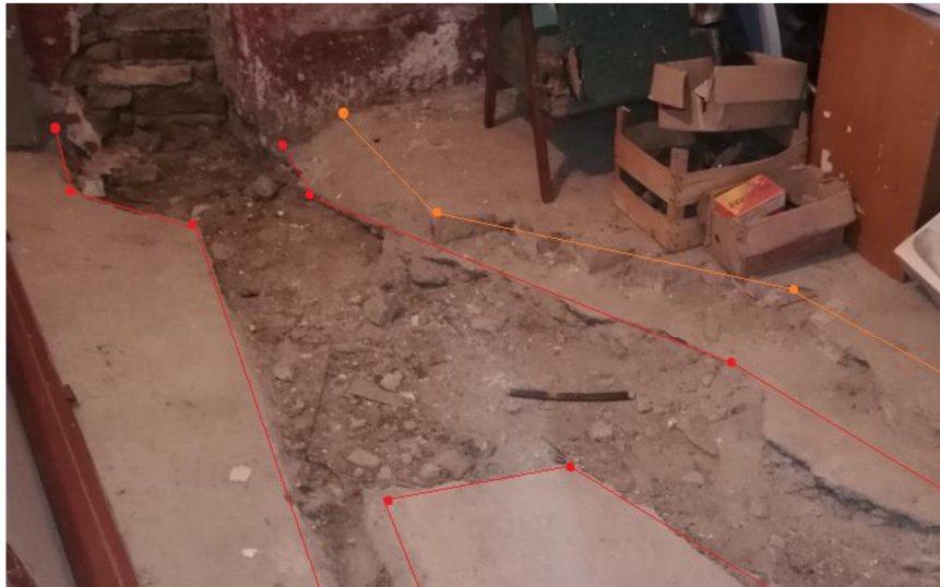
Obr. 24 Ukázka zaměření nerovnosti podlahy
