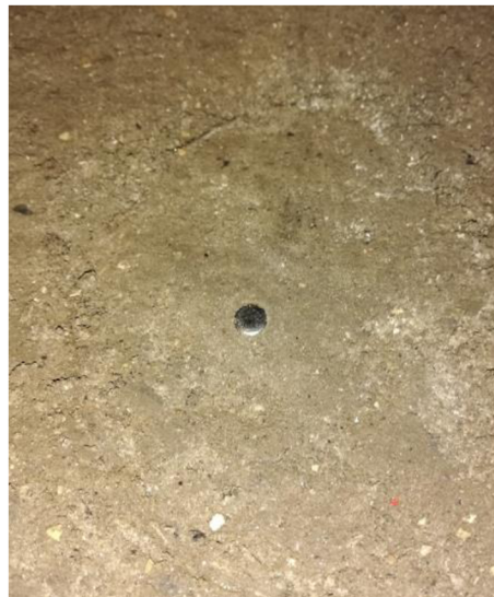
Obr. 6 Stabilizace – hřebíček
