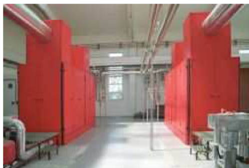
Obr. 2.11 Kogenerační jednotky v ČOV, výkon 2x 520 kW e palivo bioplyn a zemní plyn [7]
