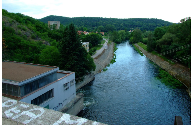
Obr. 4.5 Vodní elektrárna Brno Kníničky
