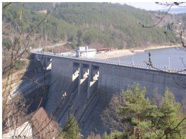
Obr. 4.6 Vodní elektrárna Orlík
