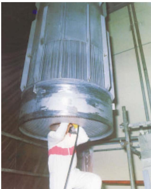
(Vlevo) Obr. 9. Oprava mezivýměníku Francouzského reaktoru Phénix. [12]
