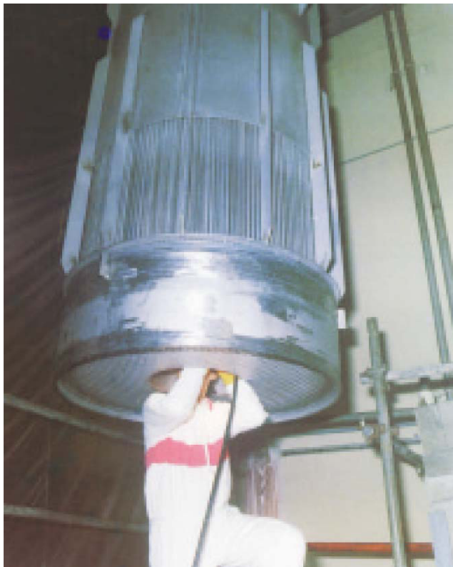
(Vlevo) Obr. 9. Oprava mezivýměníku Francouzského reaktoru Phénix. [12]
