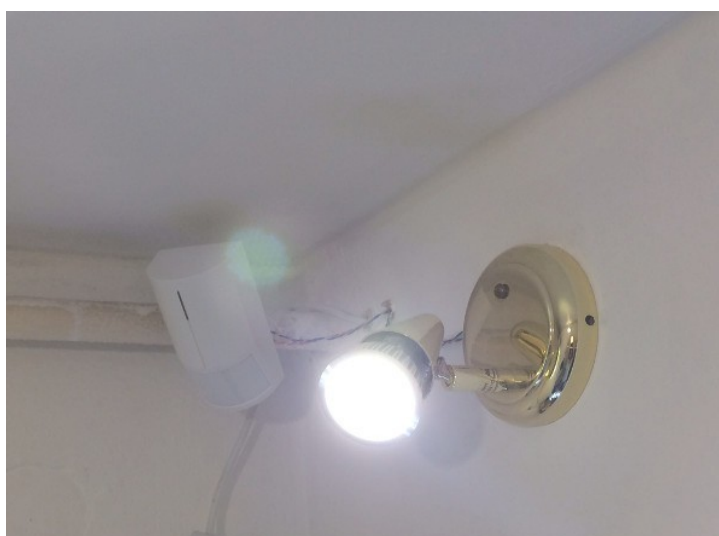
Obr. 5. Lampičky osazené LED žárovkami MR16-3W a MR16-5W.
