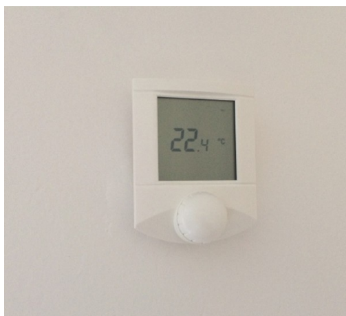
Obr. 10. Jednotka R-RC-0001R pro ovládání topení.
