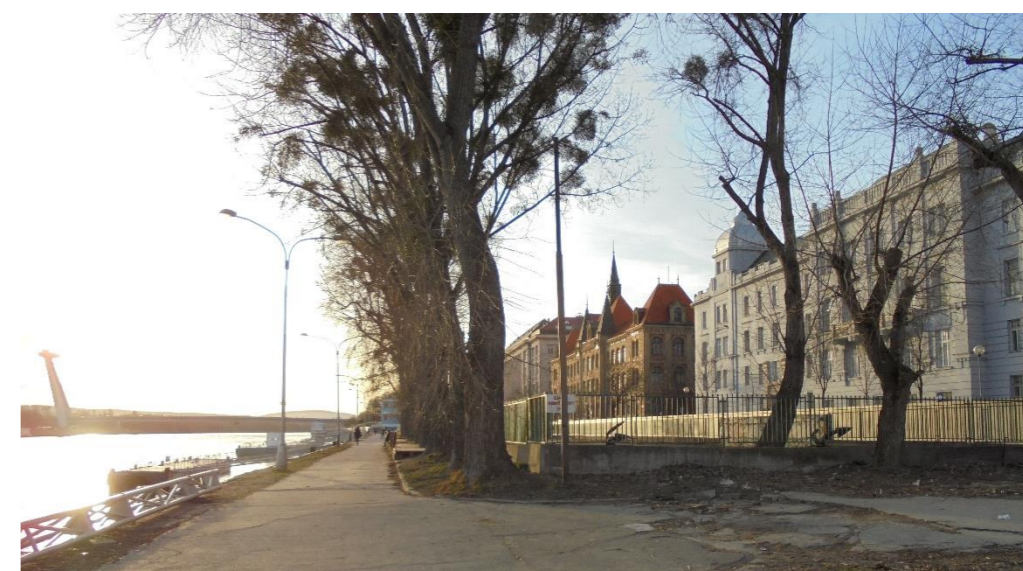
Obr. 83: Stávajúca asfaltová plocha chodníku pri rieke
