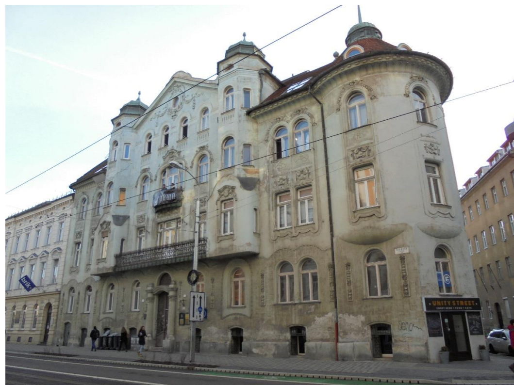
Obr. 64: Secesná budova bývalej kaviarne Tulipán
