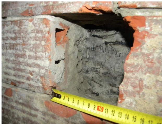
Obr. 12.5. Sonda na vnější straně obvodové zdi
