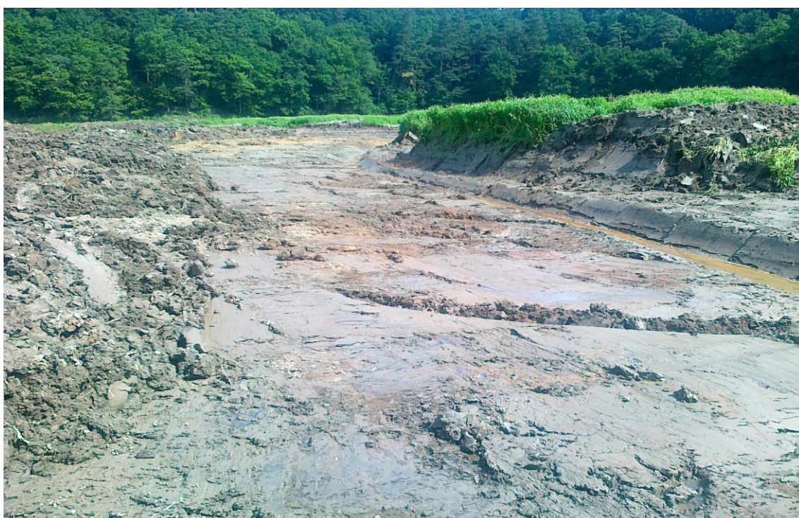
Příloha č. 7: Mocnost vrstvy sedimentu při odbahnění vodní nádrže Propast (Zdroj: František Šalda)
