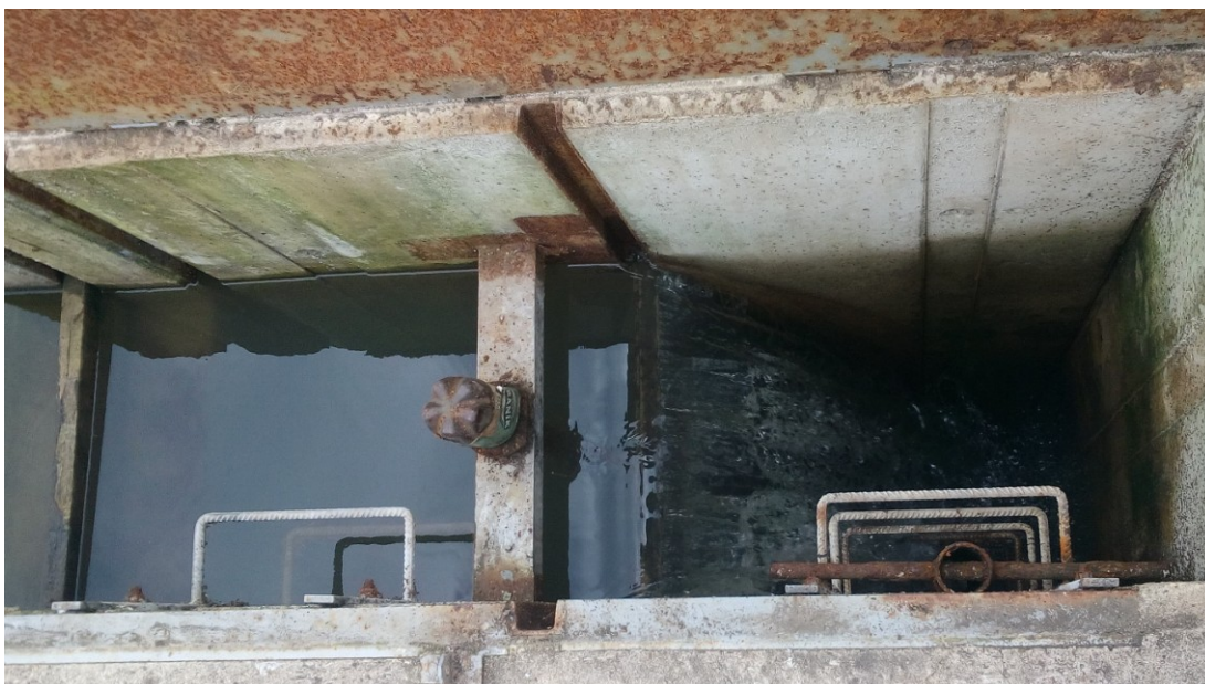
Obr. 32: Výpustné zařízení – požerák (Zdroj: fotografie autora)
