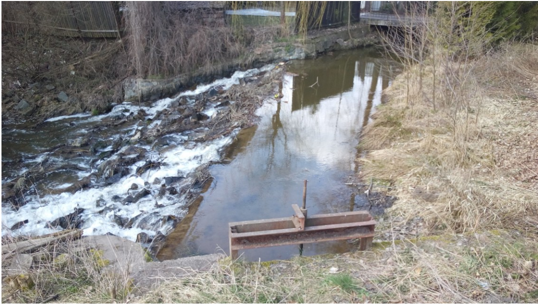
Obr. 31: Vzdouvací objekt zajišťující napájení nádrže Propast (Zdroj: fotografie autora)
