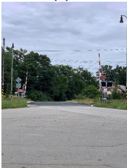
Železniční přejezd Dívčice
