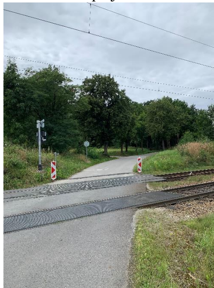
Železniční přejezd Dubenec
