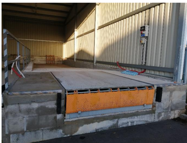
Obrázek 14 Hala N – rampa s můstkem pro vykládání palet
