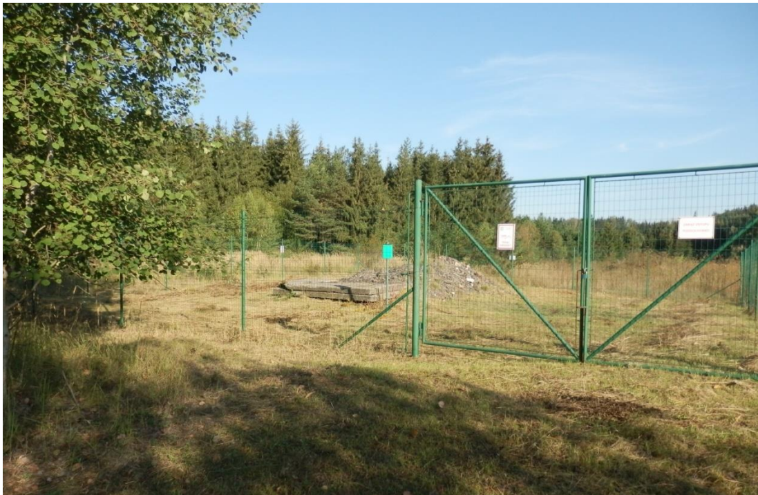
Obr. č. 9 – Zabezpečení areálu jámy č. 5
