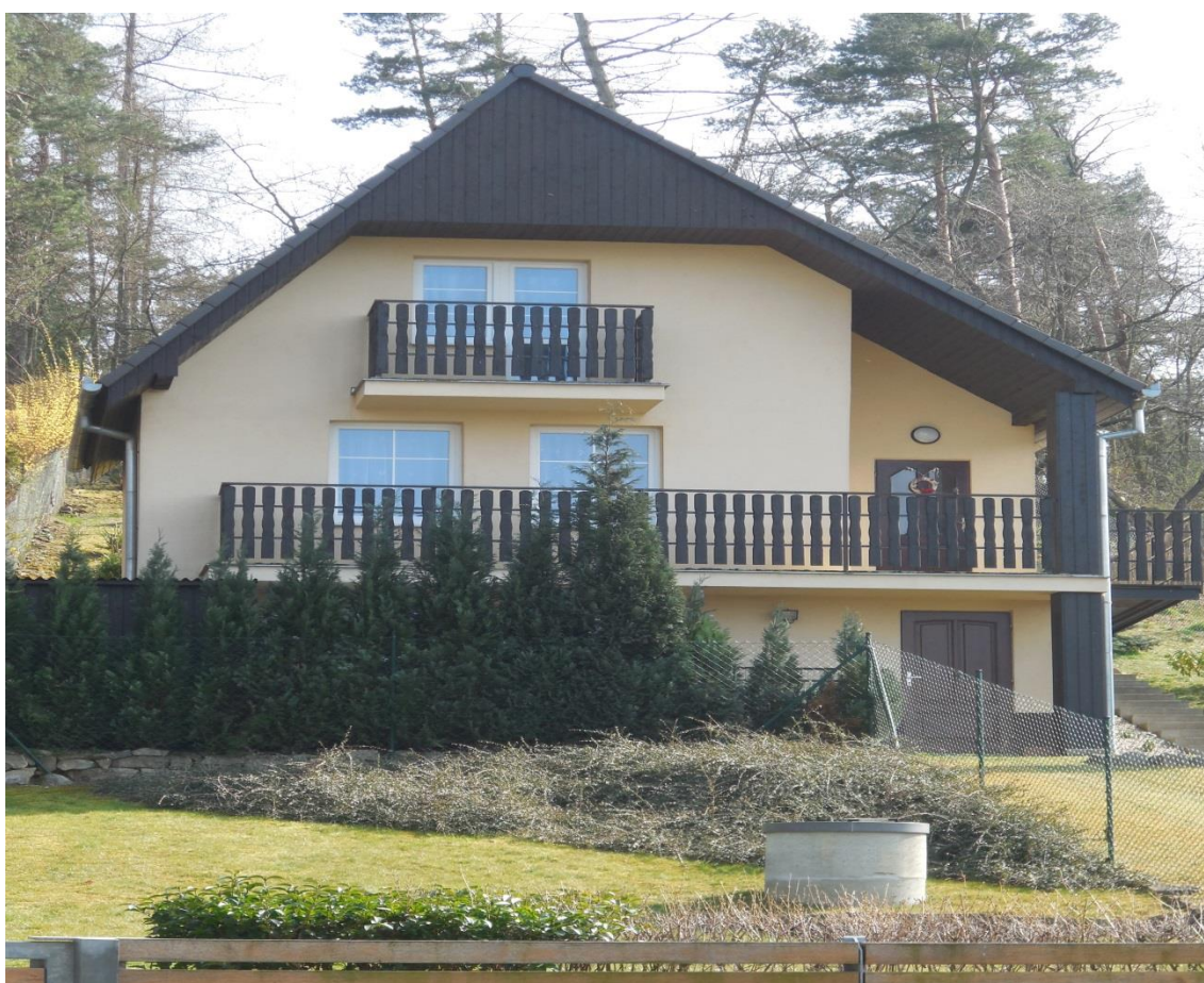
Obr. 37: Opravený objekt individuální rekreace využívaný pro rekreaci s více podlažími v Mostkovicích (zdroj: vlastní fotografie)
