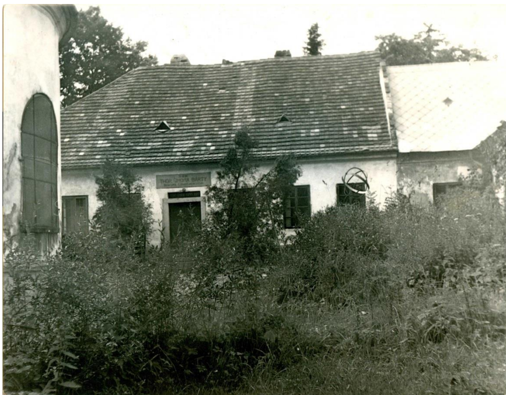
Obr. 32. Značně zpustlý a zarostlý poutní areál, zřejmě padesátá léta 20. století.
