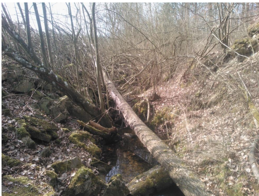
Obrázek 9: Koryto pod rybníkem Velký vyhnanický (18,528 km)
