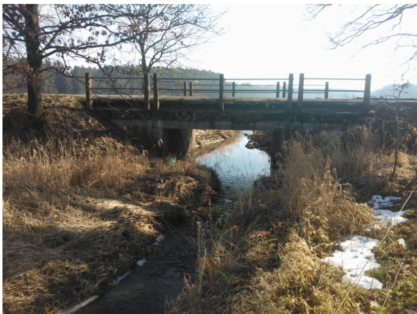
Obrázek 23: Most na silnici mezi obcemi Mažice – Vesce (7,688 km)
