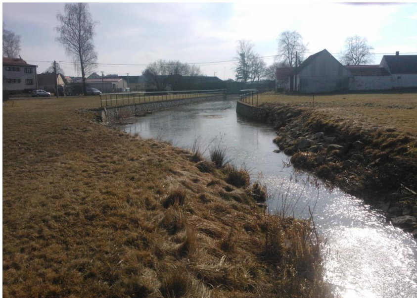
Obrázek 18: Koryto v intravilánu obce Vlastiboř (11,955 km)
