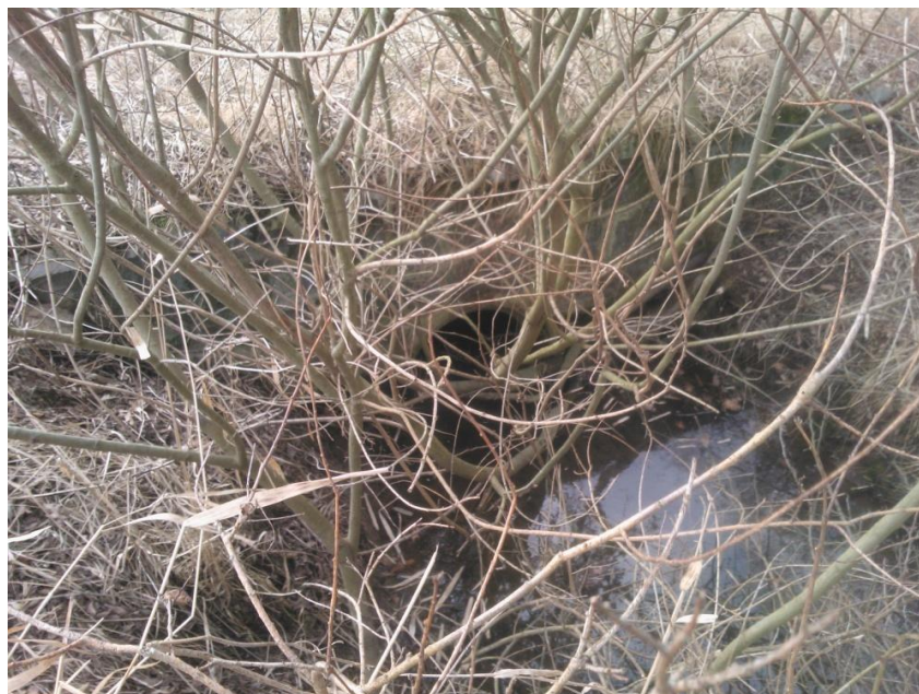
Obrázek 3: Propustek pod hrází rybníka Popov (20,050 km)
