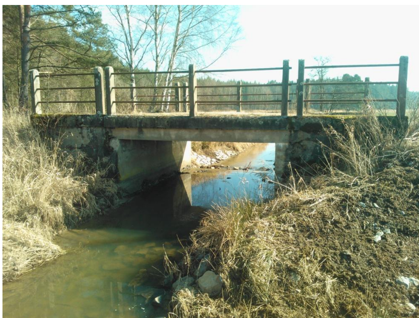
Obrázek 25: Most na polní cestě mezi obcemi Borkovice – Dráchov (6,030 km)
