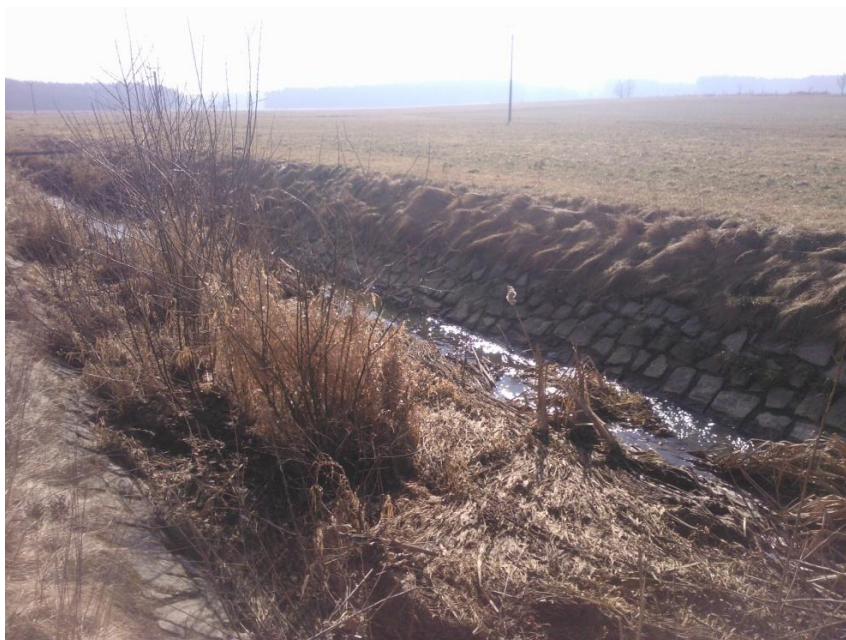
Obrázek 36: Zanesené koryto pod obcí Vlastiboř
