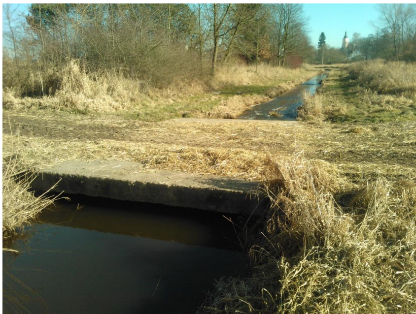
Obrázek 31: Betonový mostek pod farmou Veselí nad Lužnicí (1,657 km)
