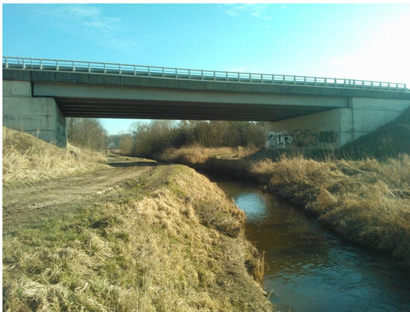
Obrázek 30: Most obchvatu Veselí nad Lužnicí (1,849 km)
