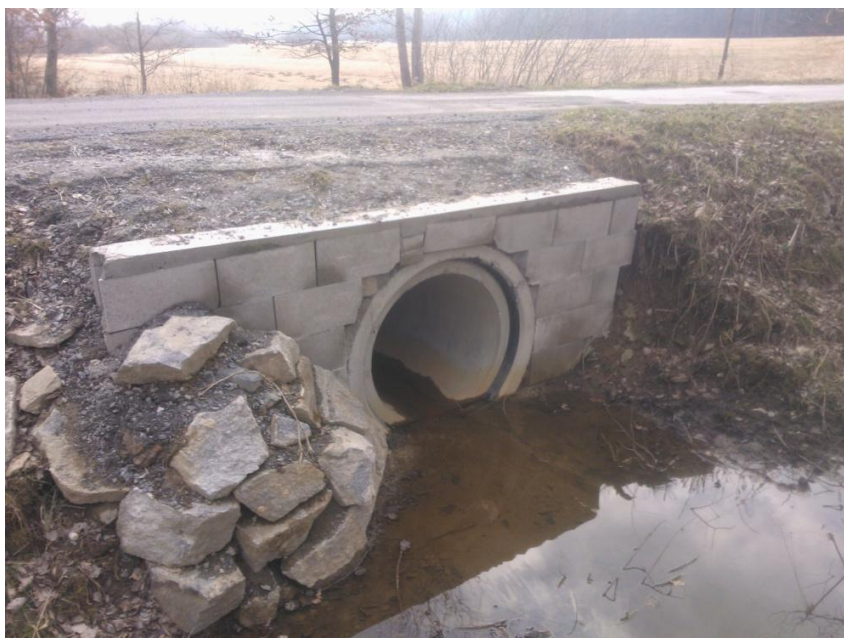
Obrázek 5: Propustek na silnici Vyhnalice – Dudov (19,482 km)
