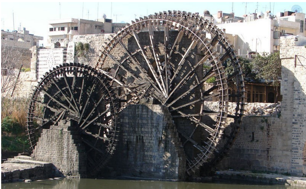
Obr. 2.7: Vodní kolo Noria pro dopravu vody, převzato z [14]
