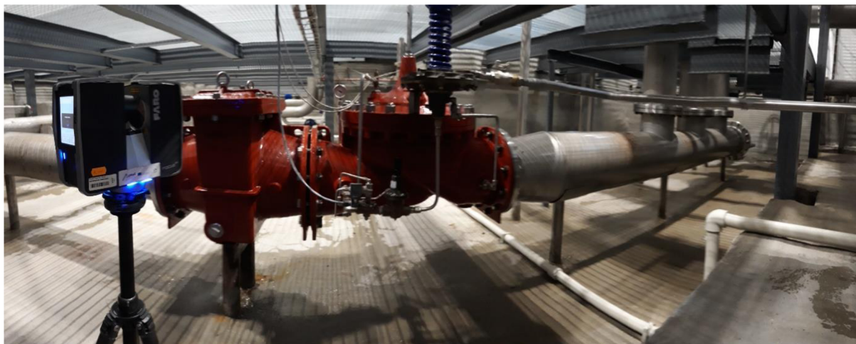
Obrázek 2: Podzemní část hlavní haly
