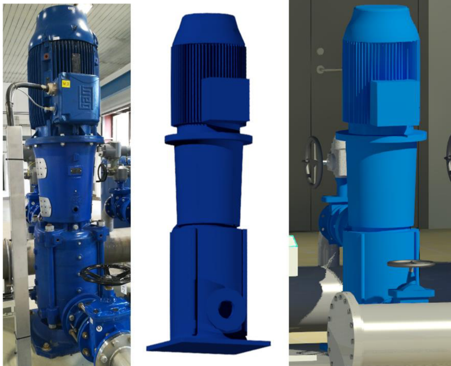
Obrázek 38: Přechod z reality-Autocad-Revit
