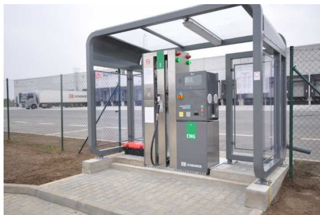
Obr. 3.1 Plnicí CNG stanice v areálu DB Schenker
