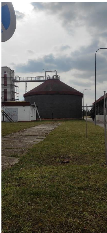
Obr. 11: Vyhnívací nádrž na ČOV Prostějov Zdroj: Vlastní fotka (2023)
