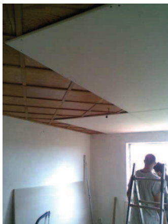
Obrázek č. 9 Podbití stropu sádrokartony
