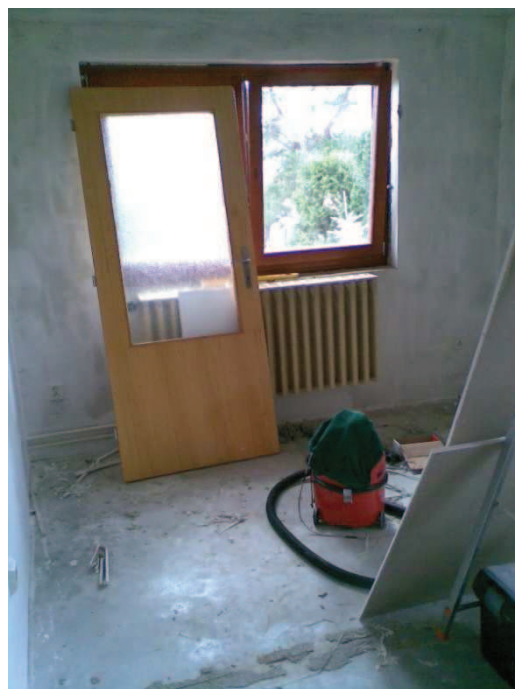
Stav po osazení okny novými.
