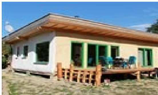
Obr.2. Slaměno-hliněný dům, postaven za 9 měsíců, náklady 1,5 milion korun
