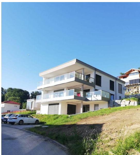
Obrázek 20 - exteriér ubytování Steinbach
