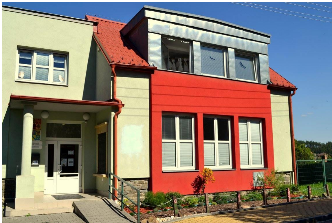
Příloha 2- Budova ZUŠ Konice, vstup
