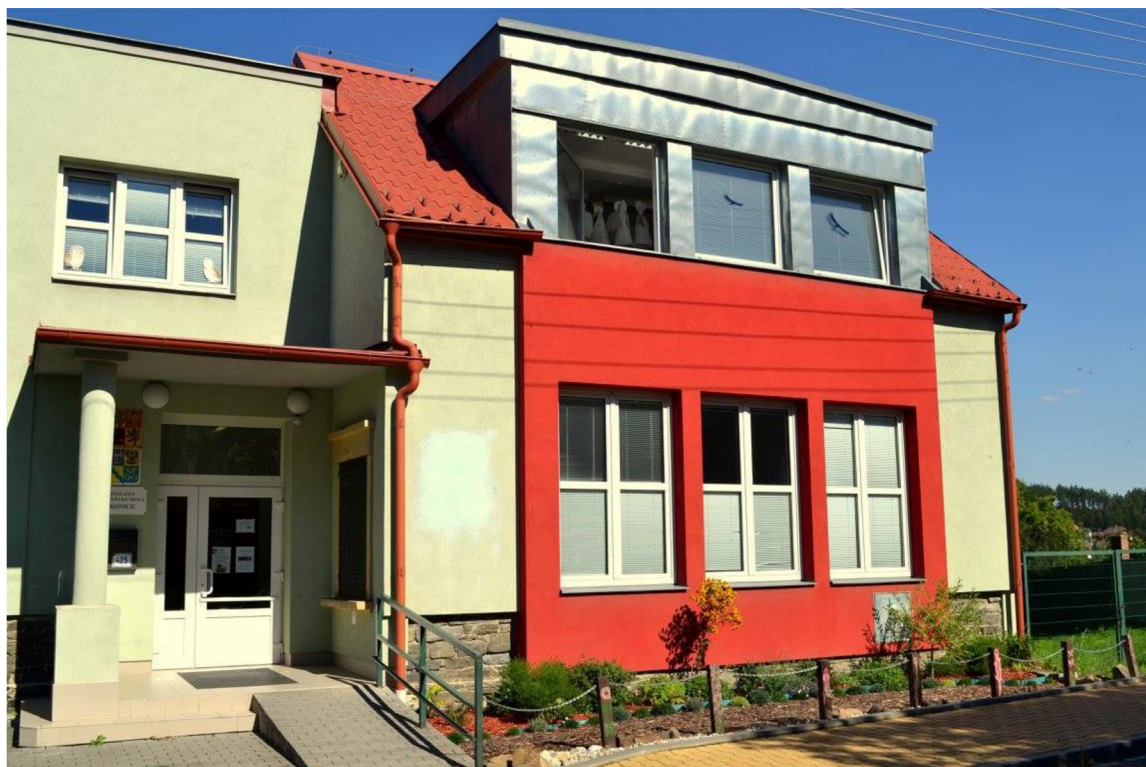
Příloha 2- Budova ZUŠ Konice, vstup
