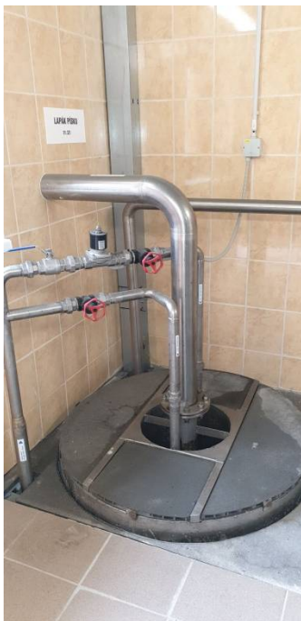
Obrázek 11: Lapák písku ČOV Louka u Litvínova (zdroj: autor práce).
