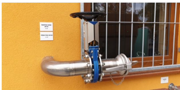
Obrázek 9: Šoupátko ČOV Louka u Litvínova (zdroj: autor práce).
