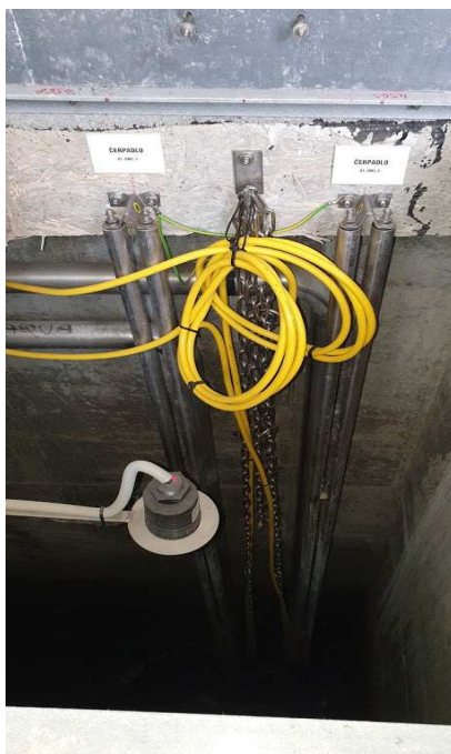
Obrázek 10: Ultrazvukový snímač čerpadel ČOV Louka u Litvínova (zdroj: autor práce).
