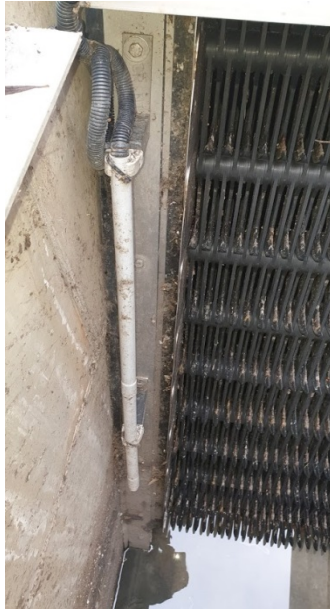
Obrázek 6: Strojně stírané česle ČOV Louka u Litvínova (zdroj: autor práce).
