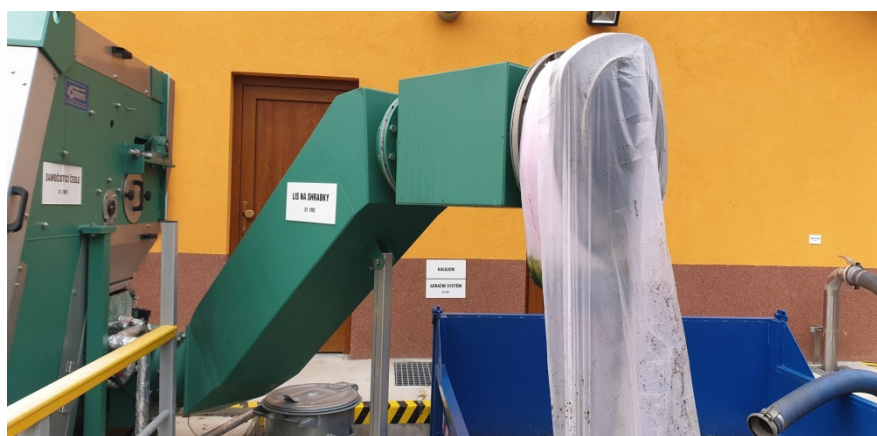
Obrázek 8: Lis na shrabky ČOV Louka u Litvínova (zdroj: autor práce).
