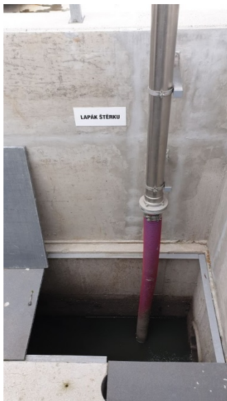
Obrázek 7: Lapák štěrků ČOV Louka u Litvínova (zdroj: autor práce).
