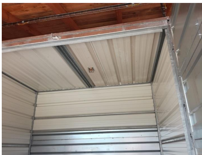
Obrázek 12 – Hasicí tryska v rozdružovači balíků
