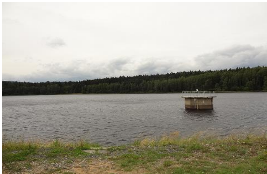
Obr. č. 28 Vodní nádrž Obecnice
