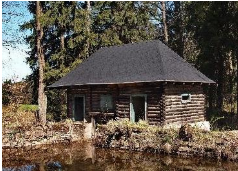
Obr. č. 19 Bývalá elektrárna u loveckého zámku Tři trubky
