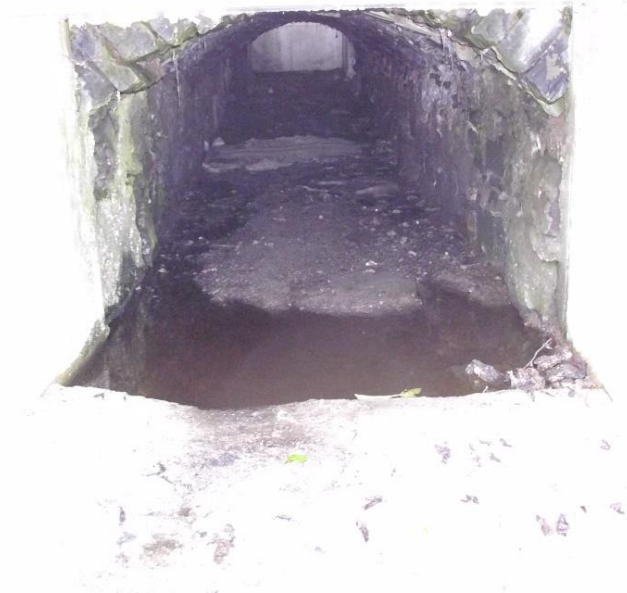
Obrázek 11: Často zaplavovaný propustek 4. (vlastní zdroj)
