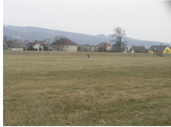
Foto 32 Protipovodňová hráz u Leštiny (Drtilová, 3/2011)
