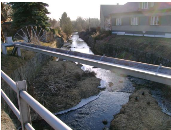
Foto 11 Koryto Loučky vydlážděné kamennou dlažbu v Lesnici (Drtilová, 3/2011)
