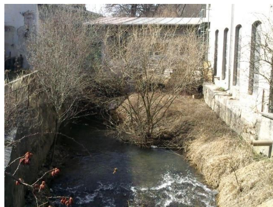
Obr. 5 Přívodní kanál k turbíně ve Vitošově (Drtilová, 3/2011)
