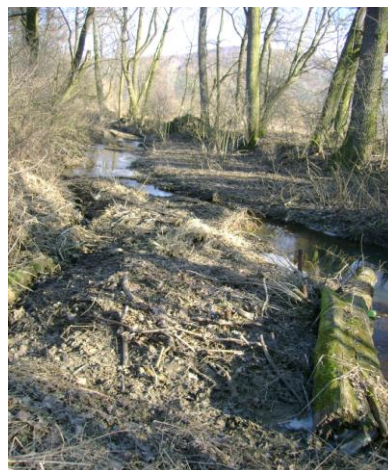
Foto 20 Zanesené koryto Vitošovského náhonu u Lesnice (Drtilová, 3/2011)
