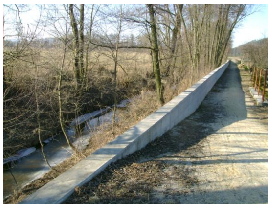
Foto 22 Betonová protipovodňová hráz za Lesnicí (Drtilová, 3/2011)
