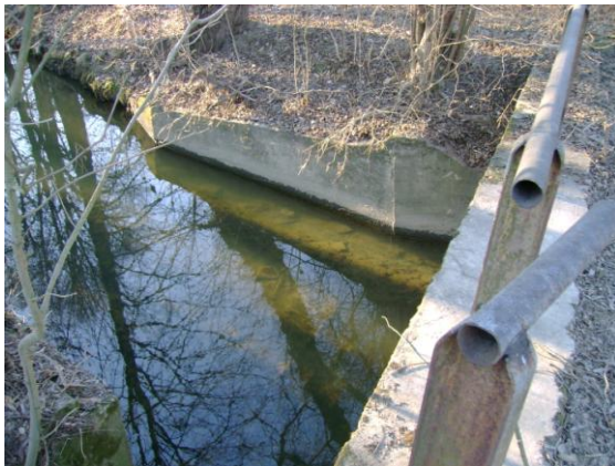
Foto 9 Betonové zpevnění Loučky před Lesnicí (Drtilová, 3/2011)
