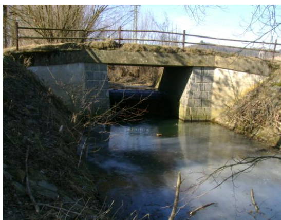
Foto 18 Přemostění Vitošovského náhonu s přepadem, zpevněné boční stěny (Drtilová, 3/2011)
