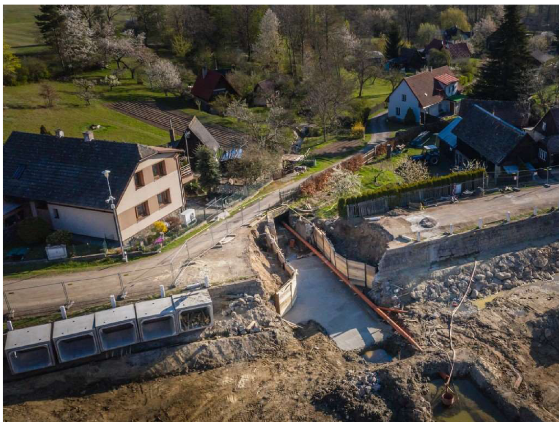
Obrázek 8: Oprava propustku silnice III/35523 Dolní Babákov [31]
