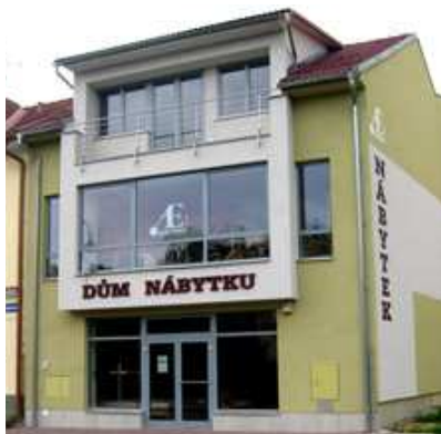
Obr. 32 Exteriér řešené prodejny
