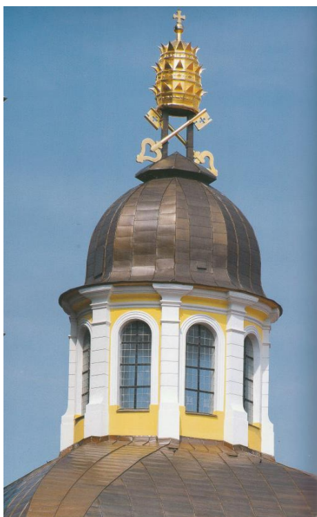
Obrázek 16: Střecha kaple sv. Klimenta v Hradci Králové (Hrubý, 2002, s. 126)
